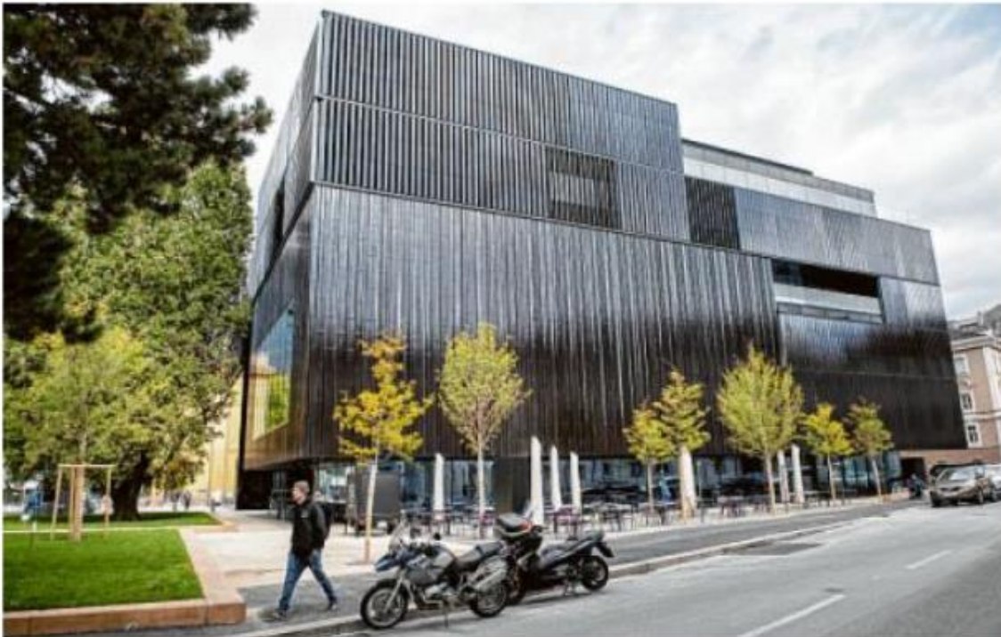
Die nachhaltige Bauweise wirkt sich positiv auf die laufenden Kosten beim Haus der Musik aus.
