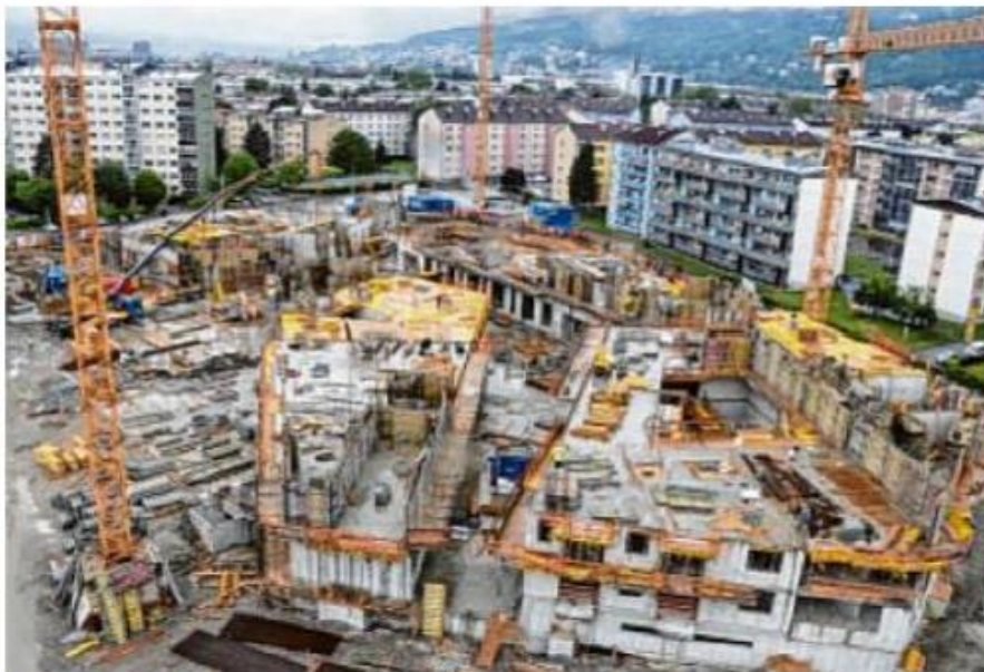
307 neue Wohnungen: Trotz Corona schreitet die Umsetzung von Baufeld eins am Campagne-Areal in der Reichenau planmäßig voran. Foto: IKM/Giuliani
