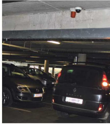
Mopedrennen in der Tiefgarage sind mit der Überwachung (Kamera oben) jetzt passé. Fotos: vk
