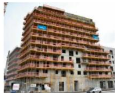
Campagne-Areal: Das Wohnprojekt nimmt Form an.
