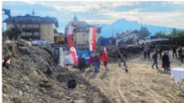
In der Baugrube des Projekts am Iglser Widumplatz wurde am Mittwoch der Spatenstich gefeiert. Dort entstehen 20 betreute Wohnungen. Foto: D&M
