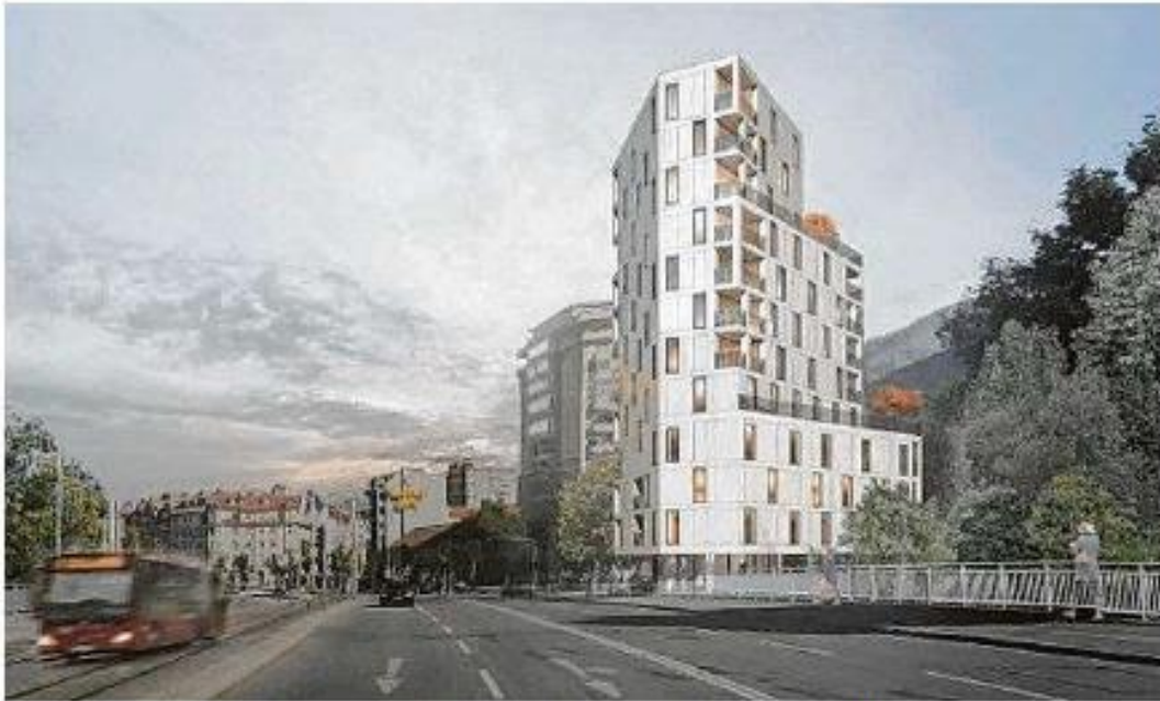
Bei der Friedensbrücke in Innsbruck entstehen 44 Stadtwohnungen, 20 davon werden als betreutes Wohnen geführt. Konzeption: schreier - weng - wiesinger
