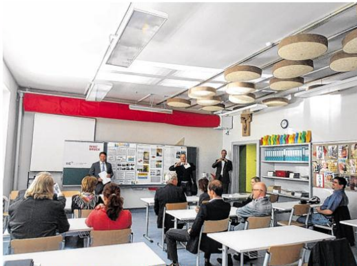
Beinahe futuristisch schaut die Deckenkonstruktion für die bessere Raumakustik aus. Bewegungsmelder sorgen dafür, dass LED-Beleuchtung sowie Belüftung nur in Betrieb sind, wenn die Klassen genutzt werden. Foto: Kuess
